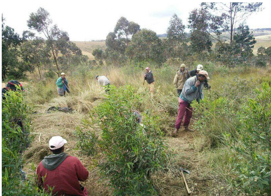
DEFRICHAGE POUR LA CONSTRUCTION D'UNE COMPOSTIÈRE,
