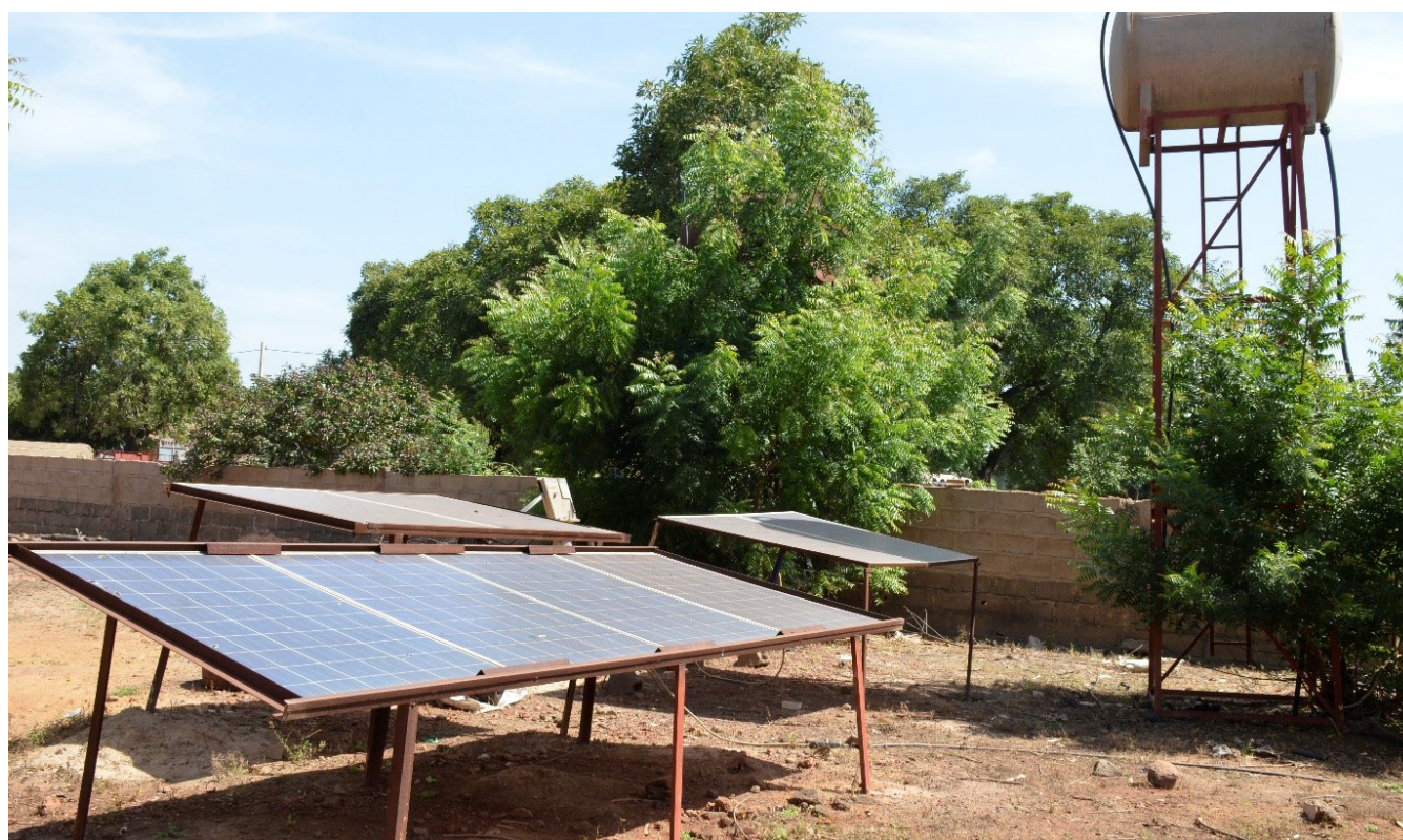
INSTALLATION DE PANNEAUX PHOTOVOLTAÏQUES DANS UN CENTRE DE SANTÉ COMMUNAUTAIRE AU BENIN
